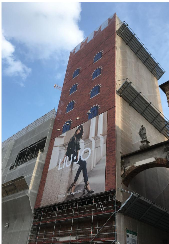
Installazione di struttura rigida vincolata a ponteggi di cantiere con posa di teli pittorici in pvc
